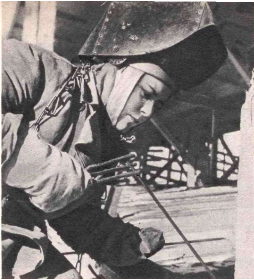
Таисия Швалюк — лучшая электросварщица стройки. Недавно строители избрали ее депутатом Балаковского горсовета.
